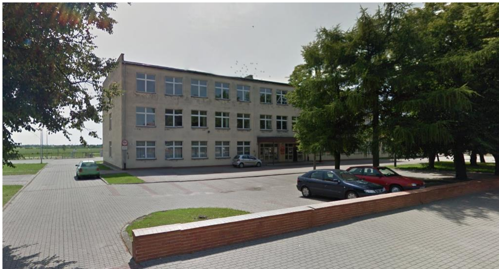
Rysunek nr 46. Budynek Zespołu Szkół w Niechanowie, który przeznaczony jest do termomodernizacji Źródło: https://www.google.pl/maps
