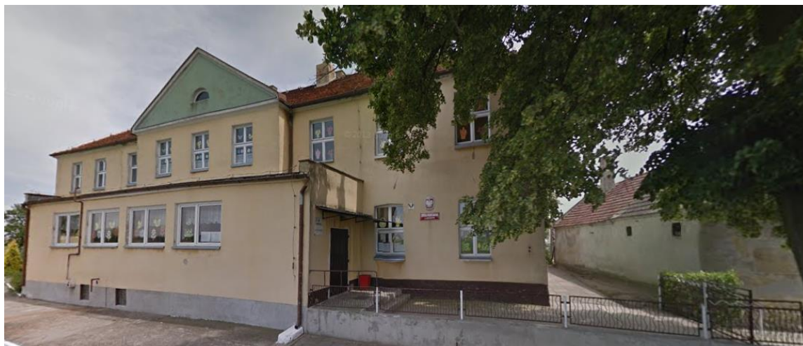
Rysunek nr 47. Budynek Szkoły Podstawowej w Jarzqbkwie, który przeznaczony jest do termomodernizacji Źródło: https://www.google.pl/maps
