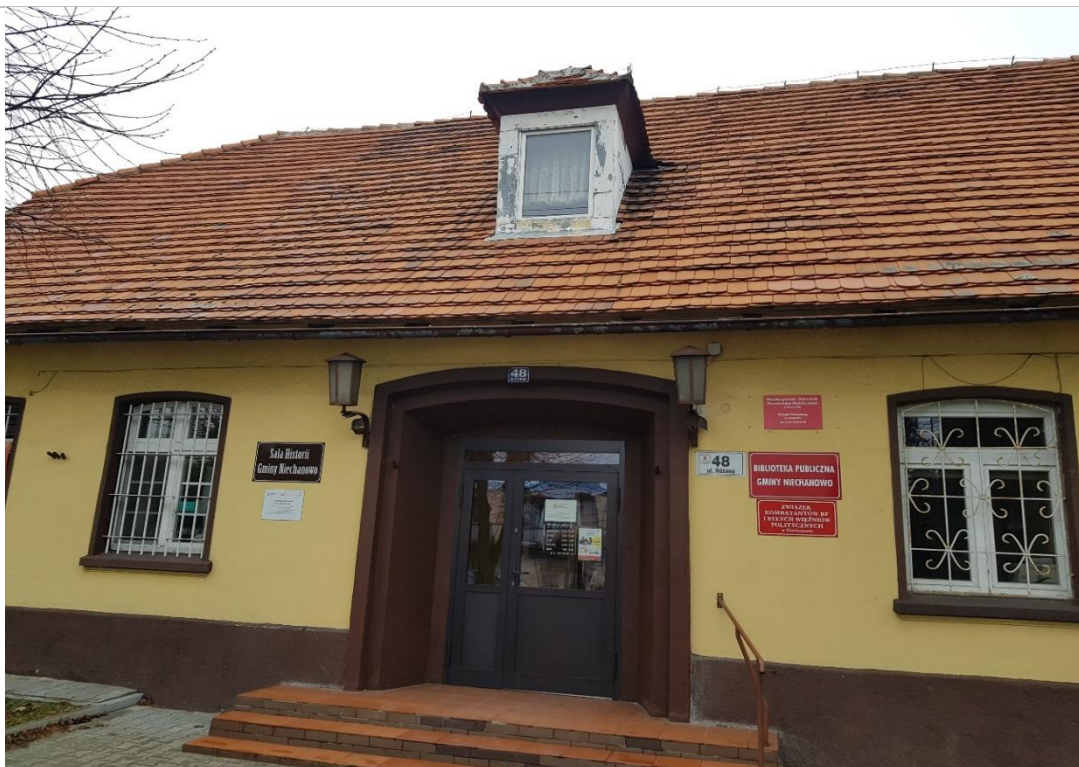
Rysunek nr 48. Budynek Biblioteki Publicznej w Niechanowie, który przeznaczony jest do termomodernizacji Źródło: Materiały własne.
